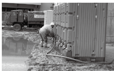
河井小学校 仮設トイレ
